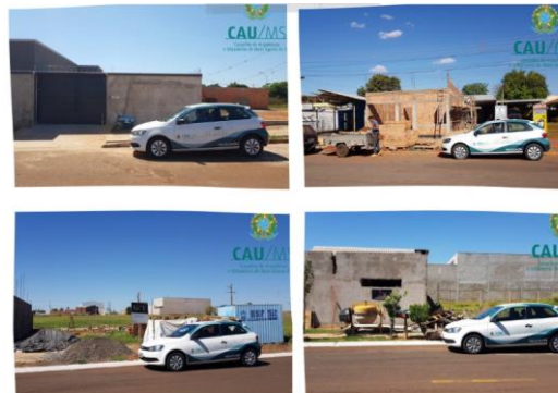
Fiscalização do CAU/MS visitou 22 obras em São Gabriel D'Oeste
